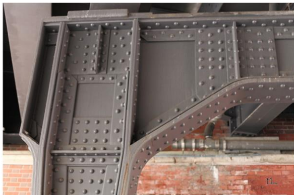
Zakovani spojevi na železničkom mostu
